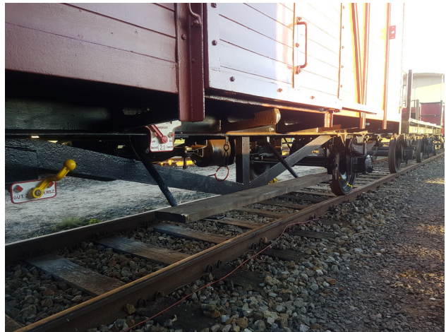
Die Bremsanlage am Gw 154 ist weitgehend montiert.
