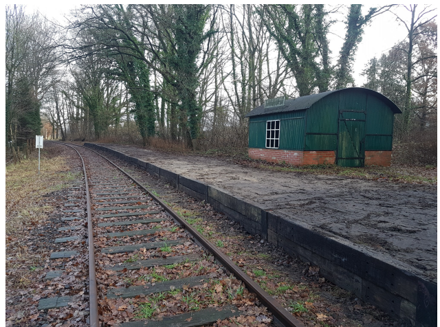
...am Haltepunkt Hohenaverbergen mit Minibagger-Hilfe.
