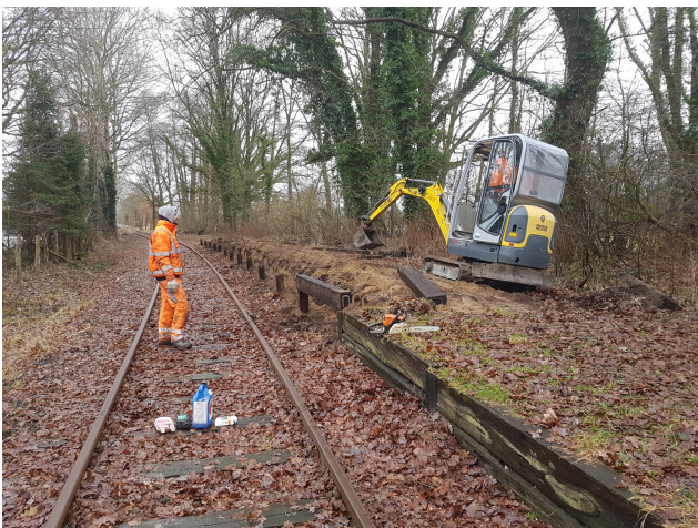
Auswechseln der morschen Bohlen der Bahnsteigkante...
