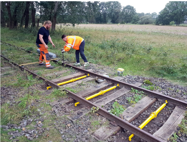
Torben und Daniel montieren Spurstangen am BÜ L 160.
