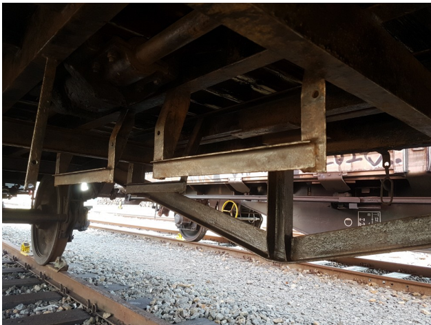
Der Rost muss ab: Schleifarbeiten unterm "Oppeln" G 154
