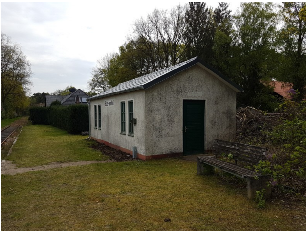
Das neue Bahnhofsdach in Eitze ist fertiggestellt.
