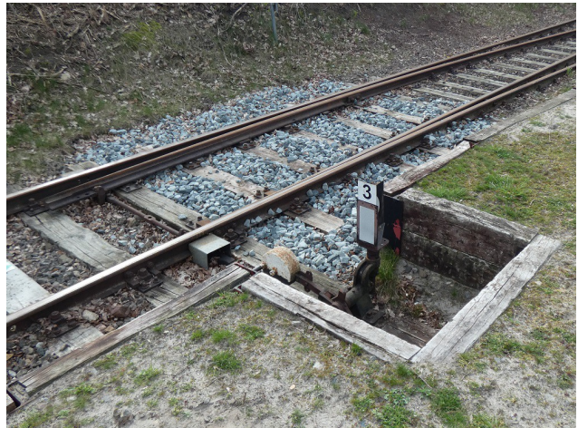
Letzte Restarbeit in Neddenaverbergen: Einbringen der Deckschicht bei den neuen Weichenschwellen.
