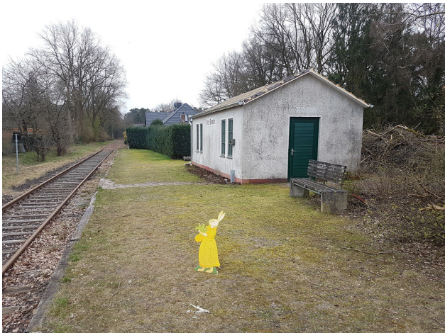
Der Osterhase verteilte die Ostereier an allen Bahnhöfen: In Eitze wird gerade das Dach des Wartehäuschens erneuert.
