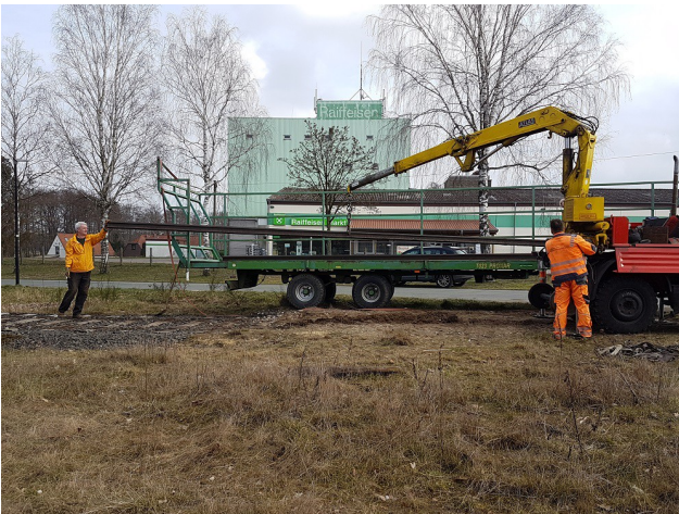
Verladung der 100 m S-49-Schienen vom früheren Gleisanschluss in der Westheide.
