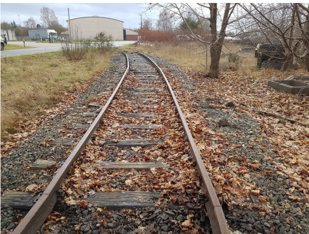
Die zu bergenden Schienen sind geschnitten, aber die Schrauben müssen noch gelöst werden.
