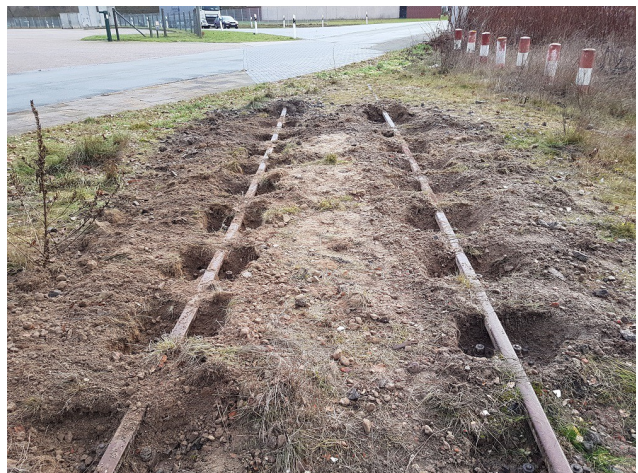
Verbuddelte Schrauben und Kleineisen sind freigelegt, damit sie Anfang 2023 losgeschraubt werden können.
