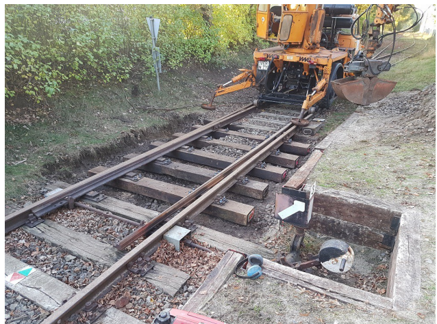
Schwellenwechsel an der Neddener Bahnsteigweiche.
