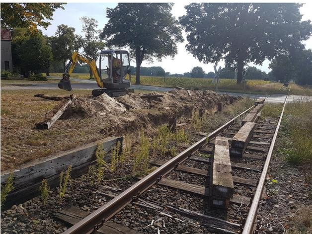
Tag 3, Mittwoch, der 17. August: Ausbaggern der restlichen Bahnsteigschwellen und Einsetzen der neuen.
