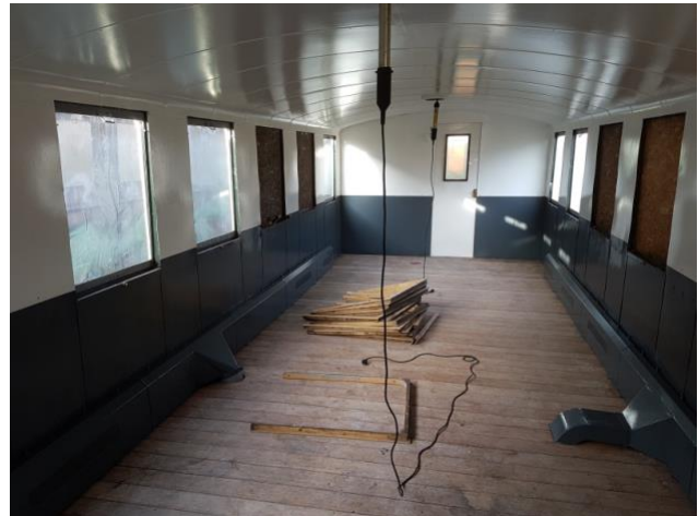
Innen fertig lackiert und mit Heizluftkanälen: Jetzt fehlen noch Bänke, Lampen und die neuen Fensterinnenrahmen.
