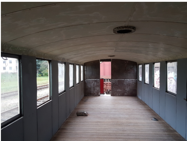
Nach Abschleifen der alten Farbe und der Montage der Wandverkleidungsleisten und des Notbremsventils wurde der Innenraum des Leesters gereinigt.
