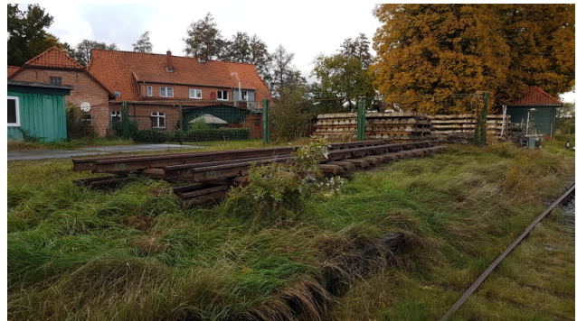
Die beiden Stahlschwellenweichen sind jetzt komplett in Stemmen angekommen und werden gegenüber dem Lokschuppen gelagert. Vielen Dank an das THW Hoya!
