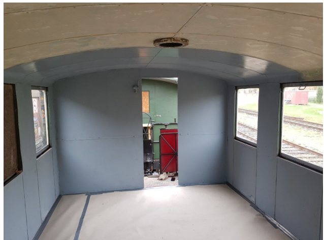
Nach dem Abkleben des Fußbodens können die noch nicht grundierten Bereiche jetzt grundiert und anschließend gestrichen werden.
