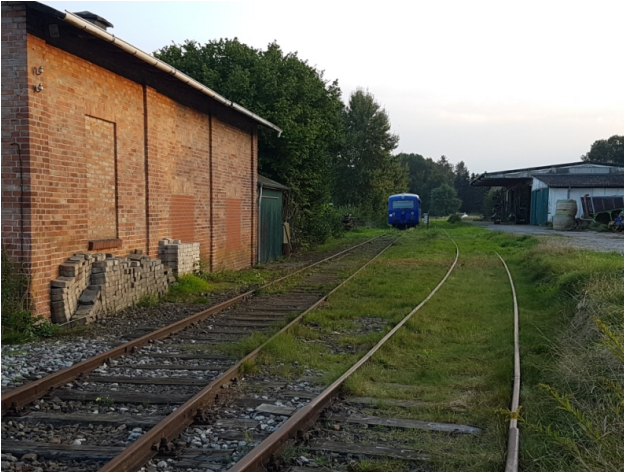
Nach dem Freischnitt sieht man wieder beide Schienenstränge des Stemmener Ladegleises rechts.
