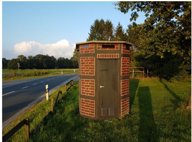
Auch das Betonhäuschen für die Schalttechnik der Blinklichtanlage am Bahnübergang Armsen wurde farblich aufgewertet und regional typischer Fachwerkarchitektur optisch angepasst. Vielen Dank für den Einsatz!
