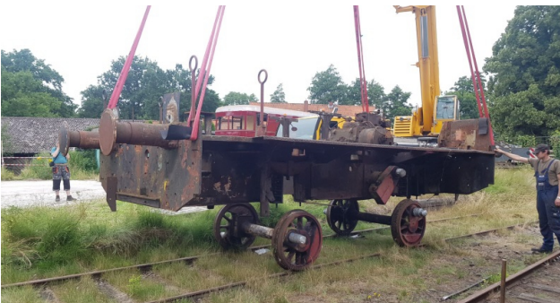
Der Rahmen der teilzerlegten Deutz-Diesellok 2 bzw. 241 wird mit dem Kran von den Radsätzen gehoben.
