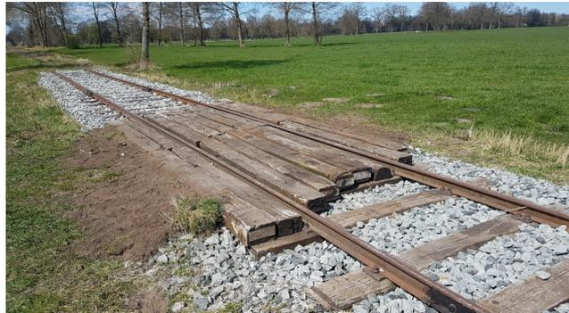
Es fehlen noch ein paar Nägel und etwas Erde für die Anrampungen, aber sonst ist der BÜ an km 10,5 fertig.
