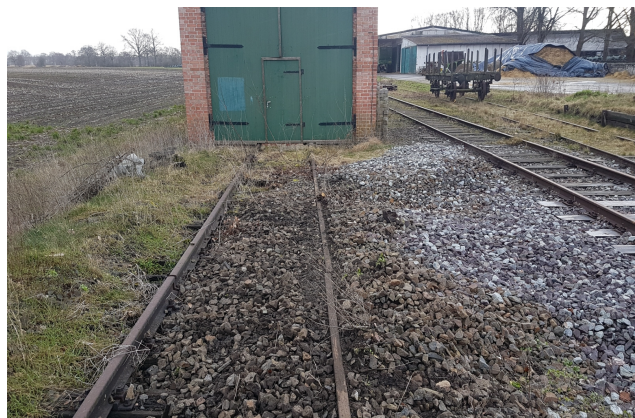
Soll Sa. noch weiter freigelegt werden: Lokschuppengleis.
