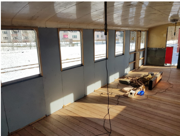
Der Innenausbau beim "Leester" schreitet voran.
